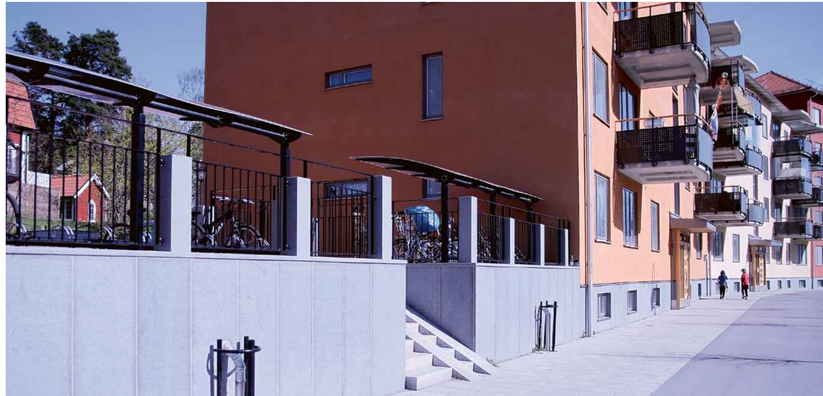
Sollentunavägen har förvandlats från väg till gata. Här finns plats för både bilister, cyklister och fotgängare. Arkitekturen är viktig för att ge gatan karaktär och bakom de nybyggda husen finns äldre hus bevarade.
